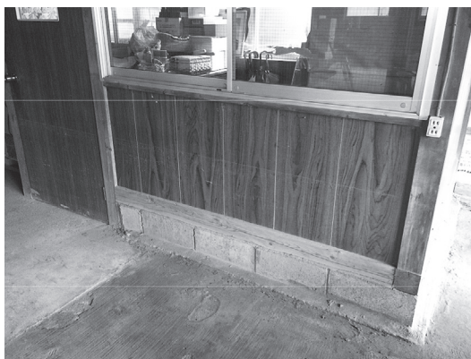
写真5 なめ清商店の浸水痕跡
