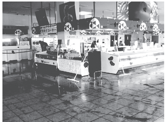
写真3 津波浸水爾における店内の状況
