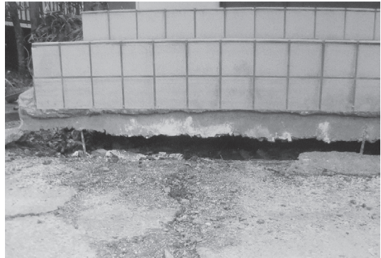
写真6 震災直後のあいりすの地盤沈下の被害 (あいりす提供)
