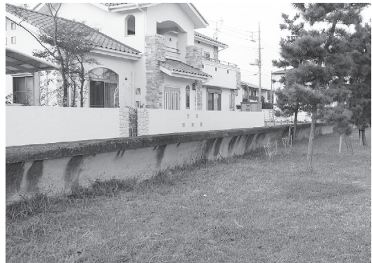
写真2 現存する旧防潮堤の一部 (2014年10月 矢ヶ崎撮影)
