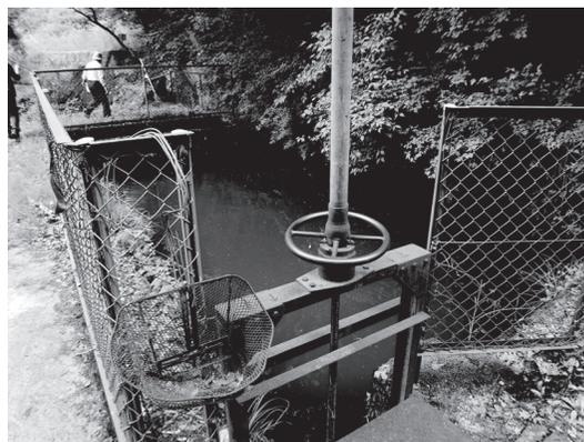
写真2 九十九折井取水口の水門と水槽
