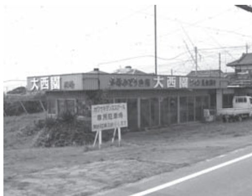
写真3 駐車場化した廃業施設
