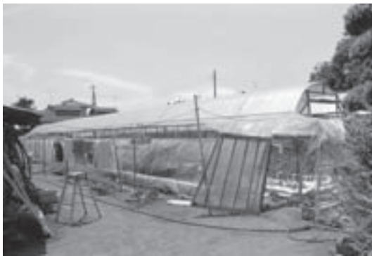
写真1 静岡型のビニールハウス 家の敷地内や近隣に建てられているハウスのほとんどはこの静岡型のハウスである。円弧型の天井と、張り出した側壁、上部の通気口に特徴がある。
