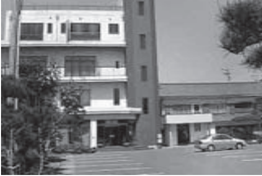
写真3 白子町中里地区における民宿の新館と旧館
