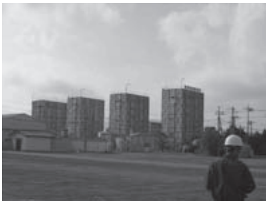
写真4 ブローイングアウト法によるヨード採取施設 （2004年10月 淡野撮影）
