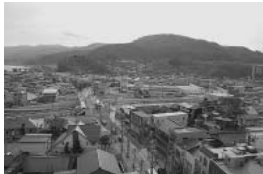
写真13 市営駐車場からみた中央本線南部と丸山タンク （2004年12月7日撮影）
