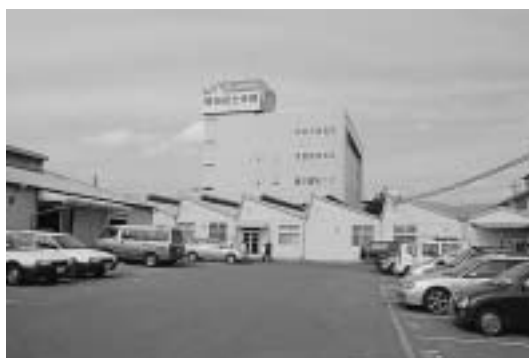
写真6 岡谷富士光機株式会社の敷地内にあるのこぎり屋根の工場 （2004年5月28日撮影）
