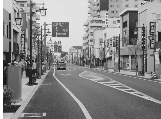
写真7 道路整備が完了した旧国道4号 歩道と車道が分離されており、街灯なども整備されている(2003年5月 藤田撮影)
