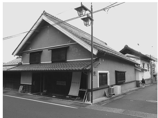
写真7 旧製糸家の建物
