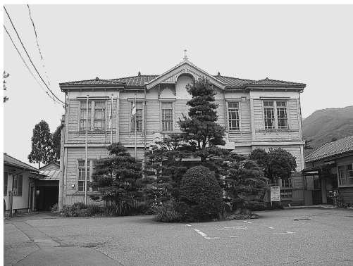
写真4 旧上高井郡役所 （2002年6月、小田撮影）
