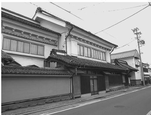
写真6 旧製糸家の建物
