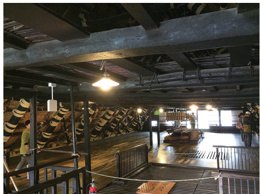
写真1 合掌造り家屋の屋根裏
