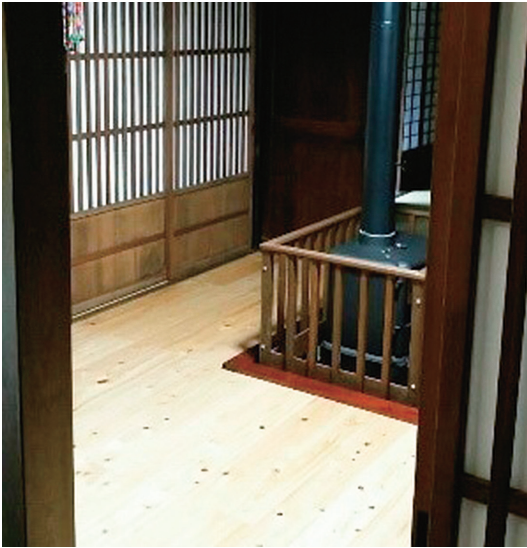
写真5 フローリング化された合掌造り家屋の床 (2015年9月田邊撮影)
