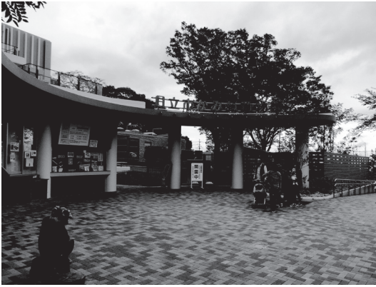
写真2 リニューアルした正面ゲート
